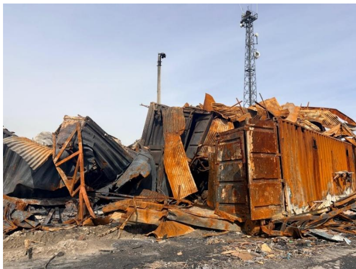
تصاویر از ساختمان های تخریب شده شفاخانه تداوی معتادین امید ۲۴ مارچ ۲۰۲۶
